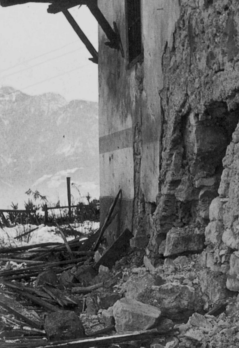
1. Februar 1961: Nur zwei Tage nach der Explosion in Waidbruck ein weiterer symbolträchtiger Anschlag: Das als Nationaldenkmal gehütete ehemalige Haus des inzwischen verstorbenen „Totengräbers Südtirols“, Ettore Tolomei, in Glen bei Montan wird schwer beschädigt.
