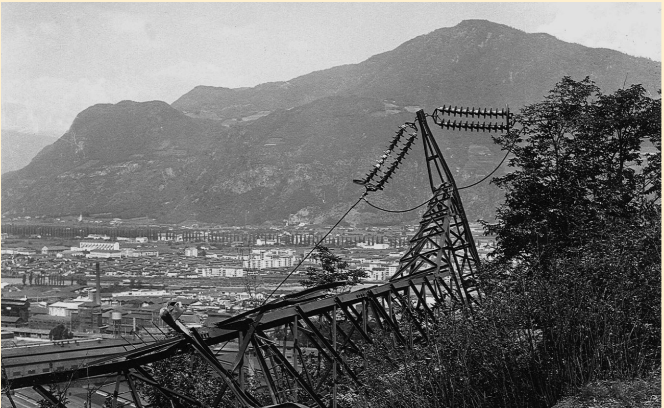
Der große Schlag des BAS: In der Nacht vom 11. auf den 12. Juni 1961 werden im ganzen Land 37 Hochspannungsmasten, zwei Hochdruckleitungen und einige Eisenbahnmasten gesprengt.
