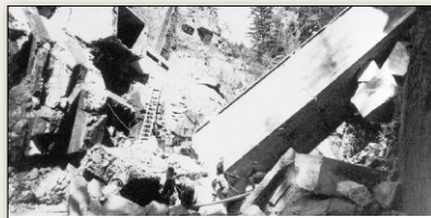
Enormen Schaden richtete die Sprengung einer Wasserbrücke über den Tanzbach im Sarntal an, das das E-Werk St. Anton speiste.
