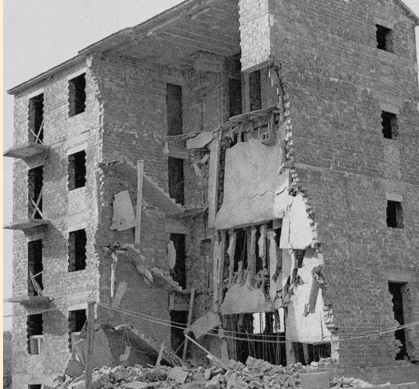
Italien feiert 100 Jahre seiner Einigung – und in Südtirol kracht es fast täglich: „Nur“ Sachschaden fordert die Bombe, die im März 1961 zwei im Rohbau stehende Volkswohnbauten in der Bozner Reschenstraße zerstört.
